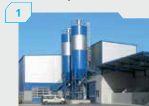
Instalacja mieszania betonu
