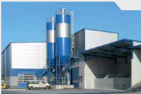
Instalacja mieszania betonu
