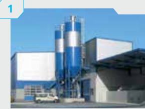
1 Beton karıştırma tesisi
