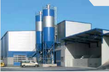
Beton harmanlama tesisi
