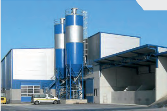
Centrale à béton
