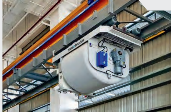
Système de transport du béton
