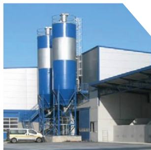
Centrale à béton
